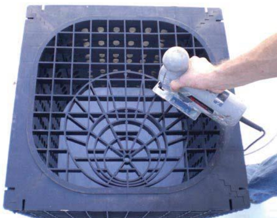
Ábra: Egy DN315 csatlakozás kivágása egy Controlbox végelemből
