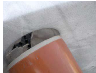
Ábra: A befolyócsövet a létrejött nyíláson át be kell vezetni. Nagyon nehezen csúszik be a cső, mivel a geotextilnek a cső és a szikkasztótömlő közé kell ragadnia, hogy a szennyeződések bekerülését elkerüljük.
