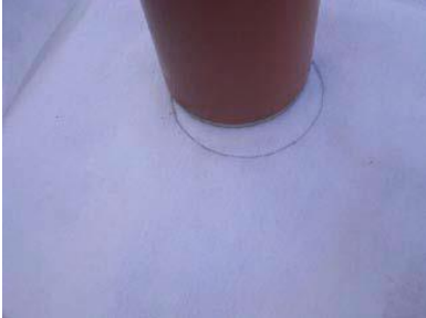
Ábra: A geotextilen a cső előrelátható helyén távolságig bevágni megrajzoljuk a kivágandó kört. E célból a későbbi befolyócső sablonként szolgálhat.
