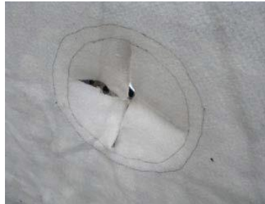
Ábra: Csillag alakban a nyílás szélétől 15 mm távolságig bevágni
