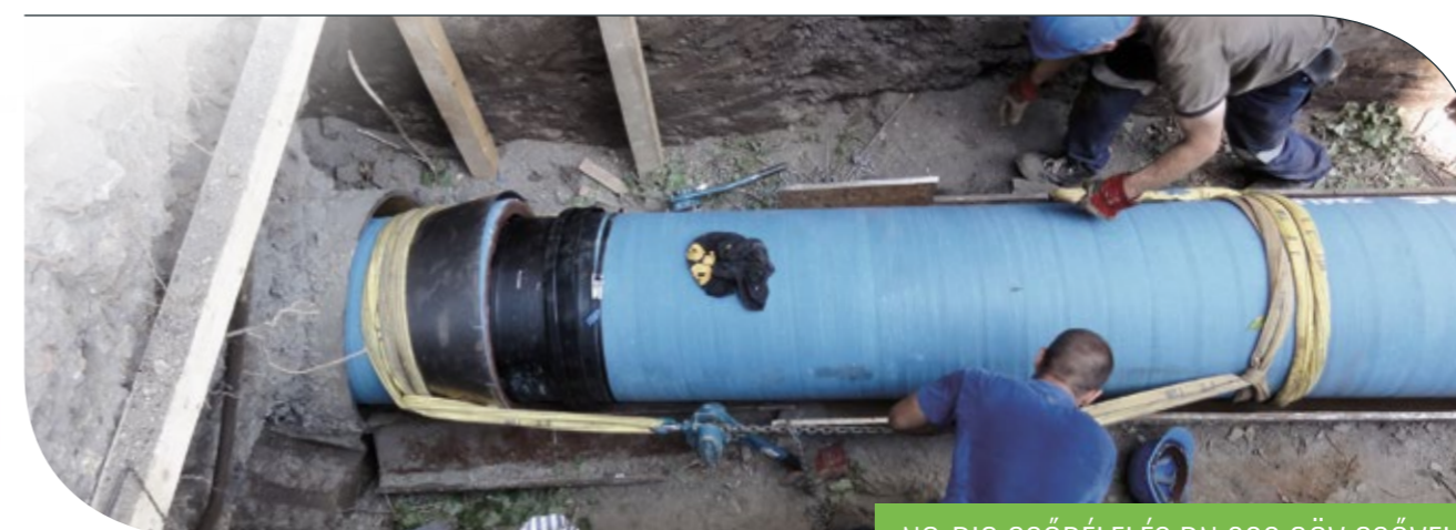
NO-DIG CSŐBÉLELÉS DN 600 GÖV CSŐVEL
