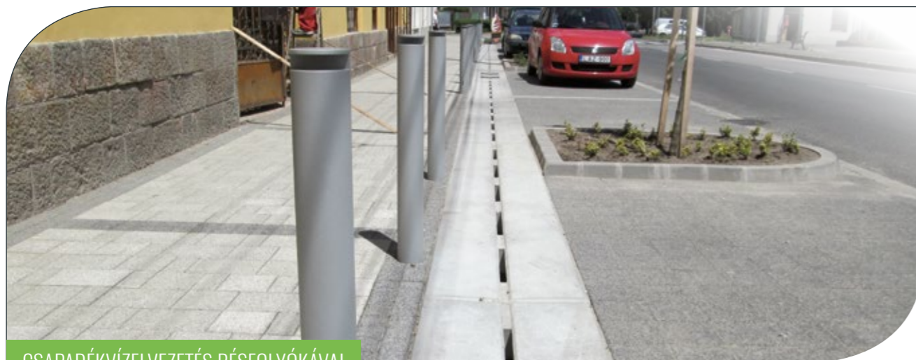
CSAPADÉKVÍZELVEZETÉS RÉSFOLYÓKÁVAL
