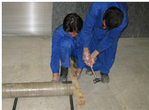
5.17 ábra: A szűkülő csővég beütése a táguló csővégebe fadarab és kalapács használatával
