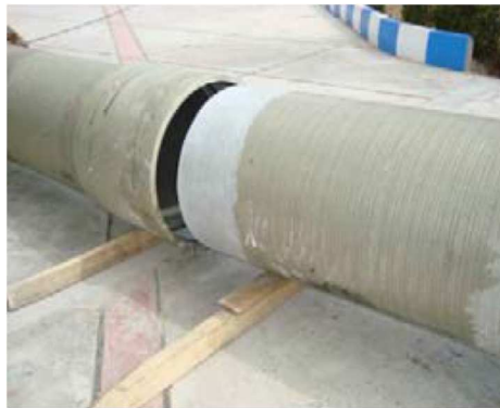
5.22 ábra: A csövek beállítása
