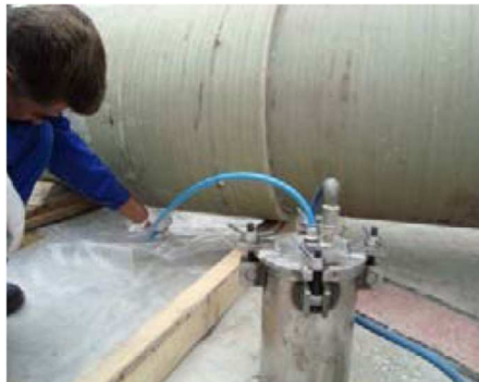
5.24 ábra: Ragasztó beinjektálása a ragasztó furatán át léggompresszorral
