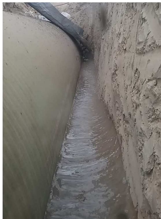
4.4 9: ÜPE cső föld alatti beépítése cementtel stabilizált talaj használatával
