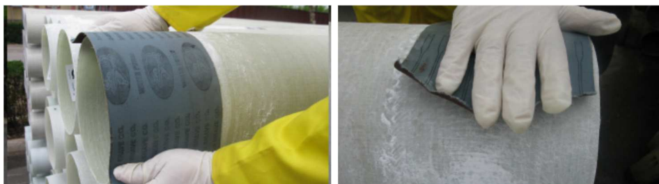
5.15 ábra: Csiszolópapír használata a szűkülő csővég külső felületén
