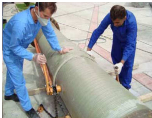
5.23 ábra: A cső behúzása feszítőszerszámmal a csőkötő idomba
