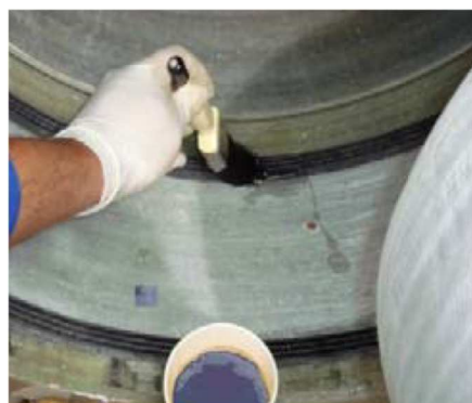
5.21 ábra: A tömítőgyűrű és a lecsiszolt felületek kenése ragasztóval és ecsettel
