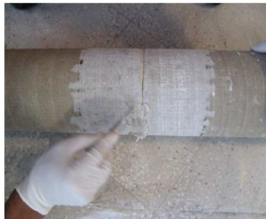
5.28 ábra: A két cső között maradt rések kitöltése gittel
