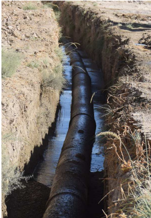
4.4 9: ÜPE cső föld alatti beépítése cementtel stabilizált talaj használatával
