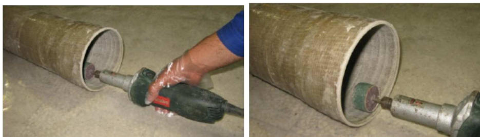
5.14: A cső belsejének megcsiszolása lyukcsiszolóval
