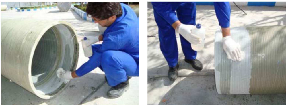
5.19: A tömítőgyűrű hornyainak és a cső lecsiszolt felületének tisztítása acetonnal és ronggyal
