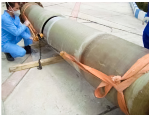
5.26. ábra: Cső behúzása a csatlakozóba
