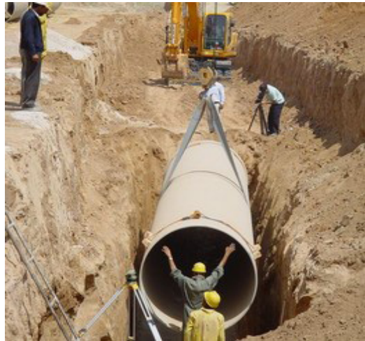
3.7. ábra: Nagy átmérőjű cső fektetése
