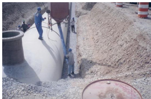
3.10. ábra: A feltöltőanyag elhelyezése földbe fektetett GRP-csövek fektetése során
