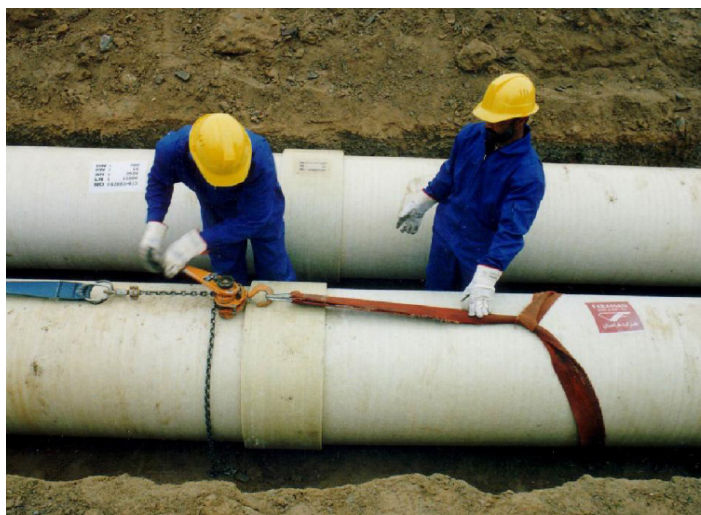
5.1. ábra: Csőösszekötési folyamat
