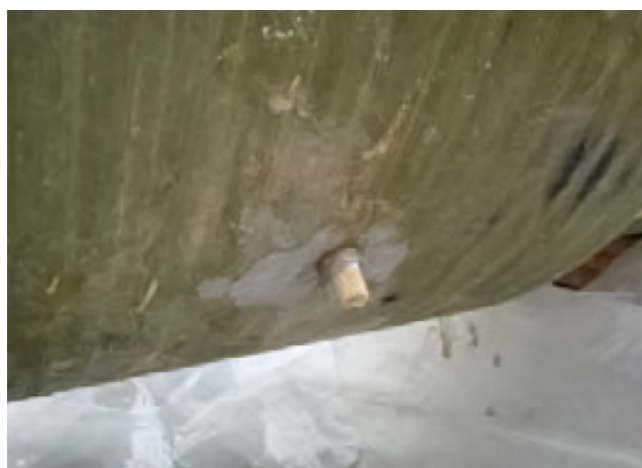
5.28. ábra: A ragasztó befecskendezése után a lyuk lezárása
