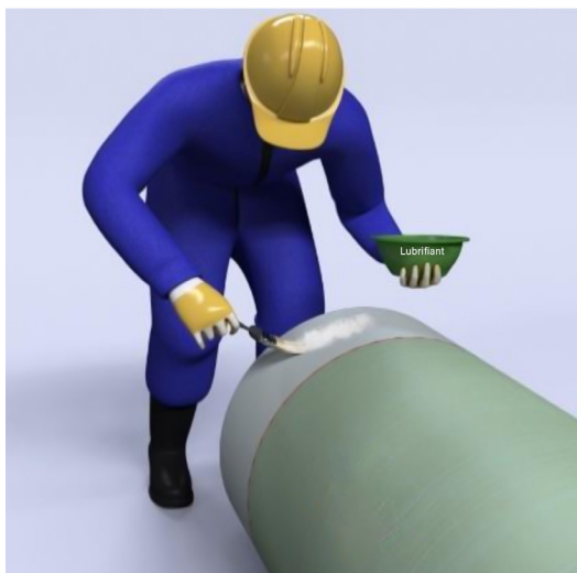
5.8. ábra: Kenőanyag felvitele a csőcsatlakozóra
