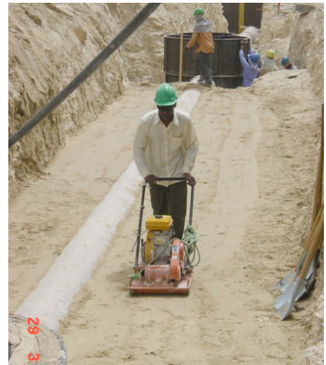
3.14 ábra: Tömörítés kézi tömörítővel
