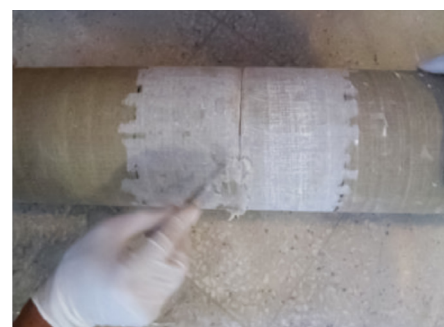
5.17. ábra: A két cső közötti rések kitöltése gitttel
