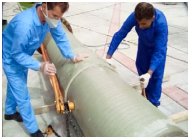
5.26. ábra: Cső behúzása a csatlakozóba
