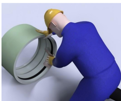
5.7. ábra A tömítés tisztítása és kenése
