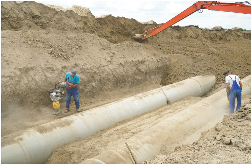
3.13 ábra: Tömörítés rezgőlemezes tömörítőgéppel
