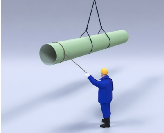
2.5. ábra: Cső emelése két támaszponttal és kezelése vezetőkötéllel
