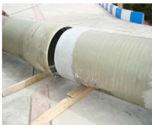
5.25. ábra: A csövek igazítása
