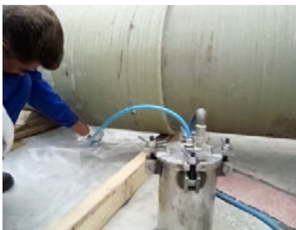
5.27. ábra: Ragasztó befecskendezése a ragasztónyíláson keresztül légkompresszor segítségével
